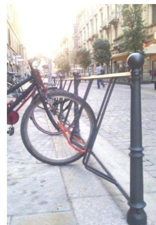
*Portabici modulare costituito da elementi in acciaio curvati montati sugli originali dissuasori tipo Milano.*
